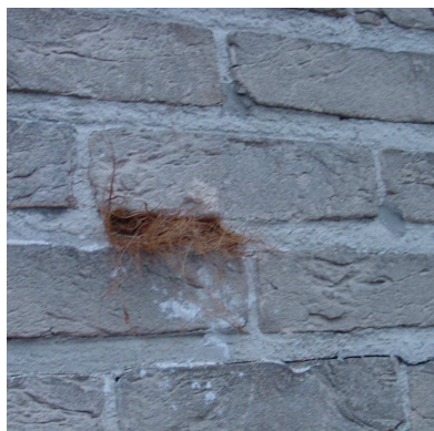
Na het vullen met korrels worden de openingen tijdelijk volgestopt met bijvoorbeeld kokos.
