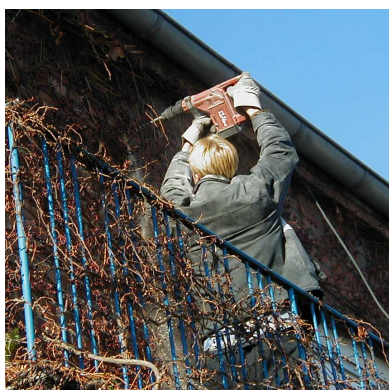
Openingen boren met een diameter van 24 mm.
