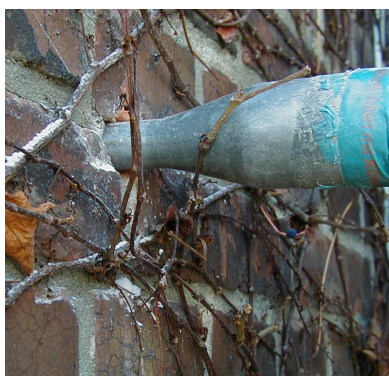
Inblazen van silicaat-schuimkorrels SLS ® 20F.
