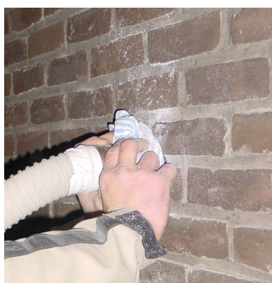
De SLS ® 20F-korrels kunnen ook worden ingeblazen door openingen van \pm 14 \times 70 mm.
