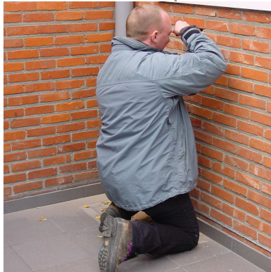
Inspectie van de spouwmuur met een endoscoop.
